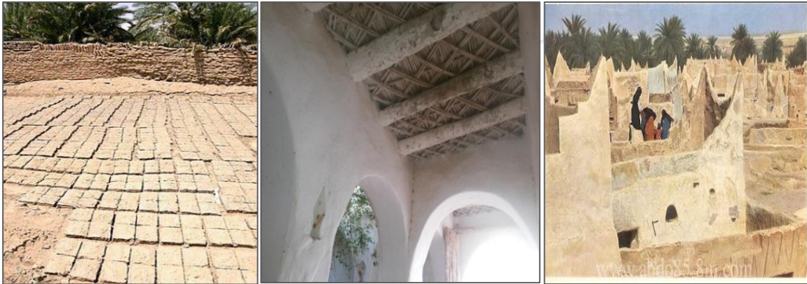
أرضيات من الطين والحجر المجفف أسقف المباني المصنوعة من جذوع النخيل الجدران المصنوعة من الطين الشكل (2): مواد البناء والتشطيبات في العمارة الصحراوية المحلية، المصدر: www.Mirathlibya 2012
