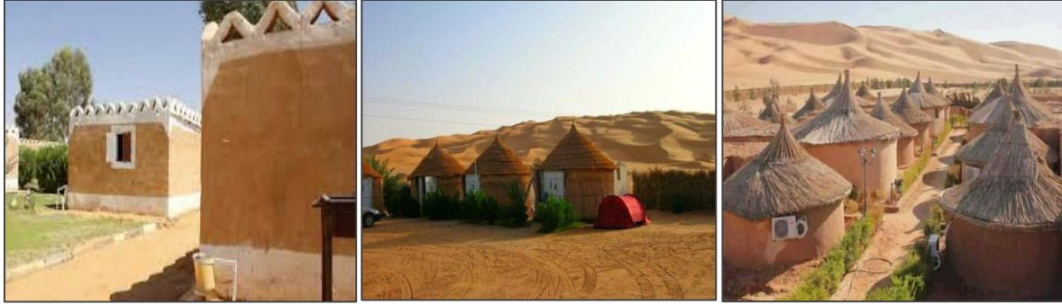
الشكل (6): مواد البناء والتشييد في منتجج قمر الصحراء، المصدر: منتجج قمر الصحراء 2004.
